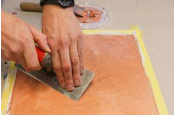
Polieren mit der Federstahlkelle
